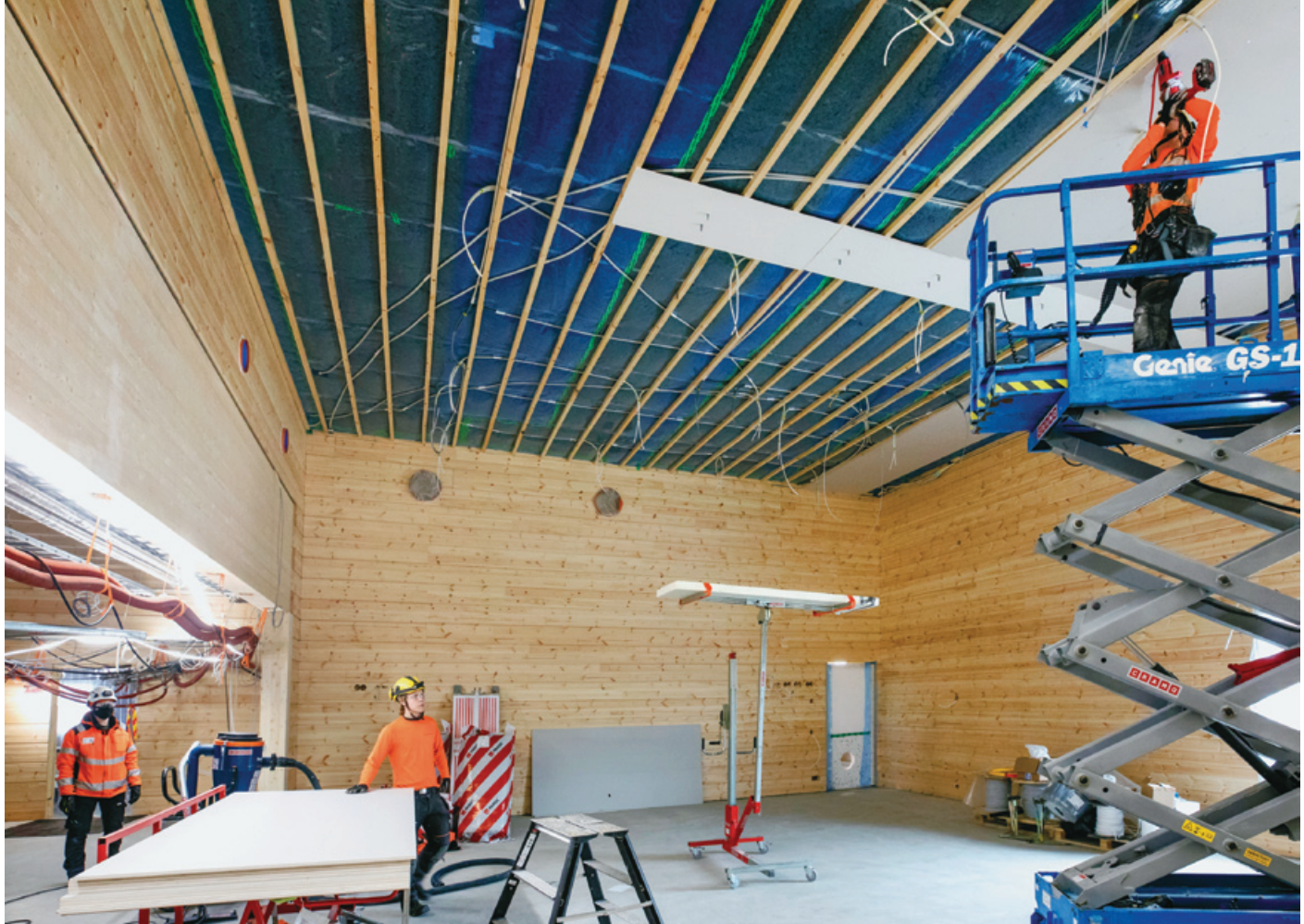
Pajarinrannan päiväkodin liikuntasalia vuokrataan myös ulkopuolisille, kun se ei ole päiväkodin käytössä. Kuvassa vas. vastaava työnjohtaja Matias Rautakoski sekä rakentajat Tuomas Vänntilä ja Joona Nissinen.
