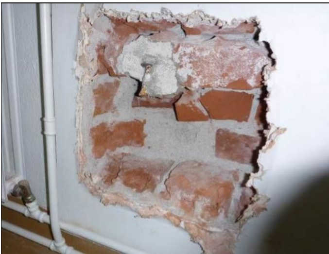
Kuva 20. Tilan 105 ulkoseinän rakenneavaus (US1) Ulkoseinä on massiivirakenteinen, tiilen ja Siporex-harkon välissä on 10 mm ilmarako
