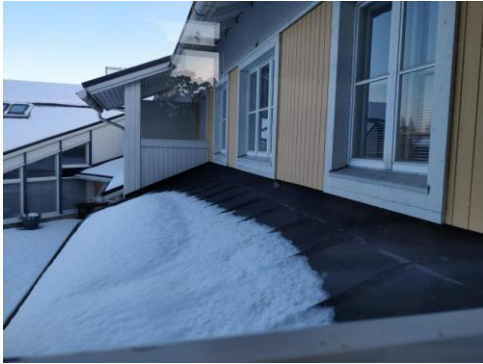
Kuva 11 Vesikatetta matalalla osalla
