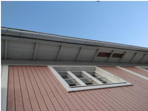
Kuva 14 Räystäät siistit, vesikourut ehjät
