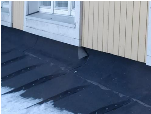
Kuva 12 Nostot paikoin irronneet
