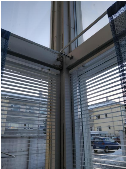
Kuva 31 korkeissa ikkunoissa puuosissa hilseilyä; kondenssi?
