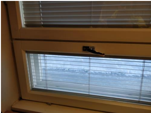
Kuva 30 ikkunoiden avausmekanismit reistaavat
