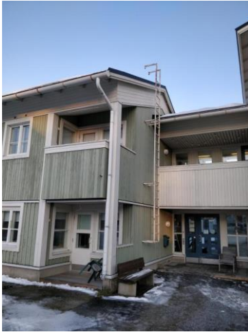
Kuva 17 Julkisiverhous ja otsalauδοitukset siistit
