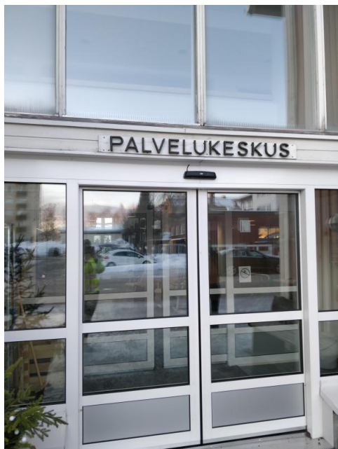
Kuva 32 pääovi sähkötoiminen, hyväkuntoinen
