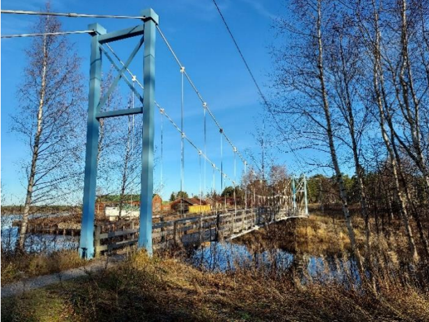
Kuva 8. Kaava-alueelta Sotisaareen johtava kevyenliikenteen silta.
