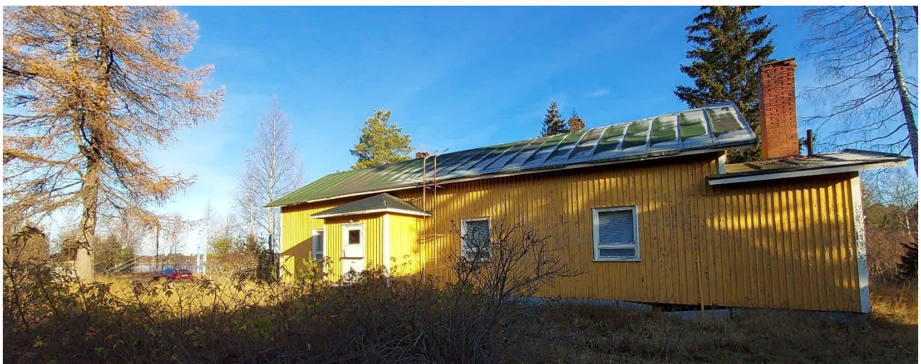
Kuva 18. Alueella sijaitseva vanha asuinrakennus.
